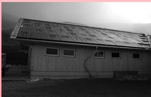
Photovoltaikanlage auf dem Schrägdach der neu erstellten Rinderhütte auf Widerfeld First.
